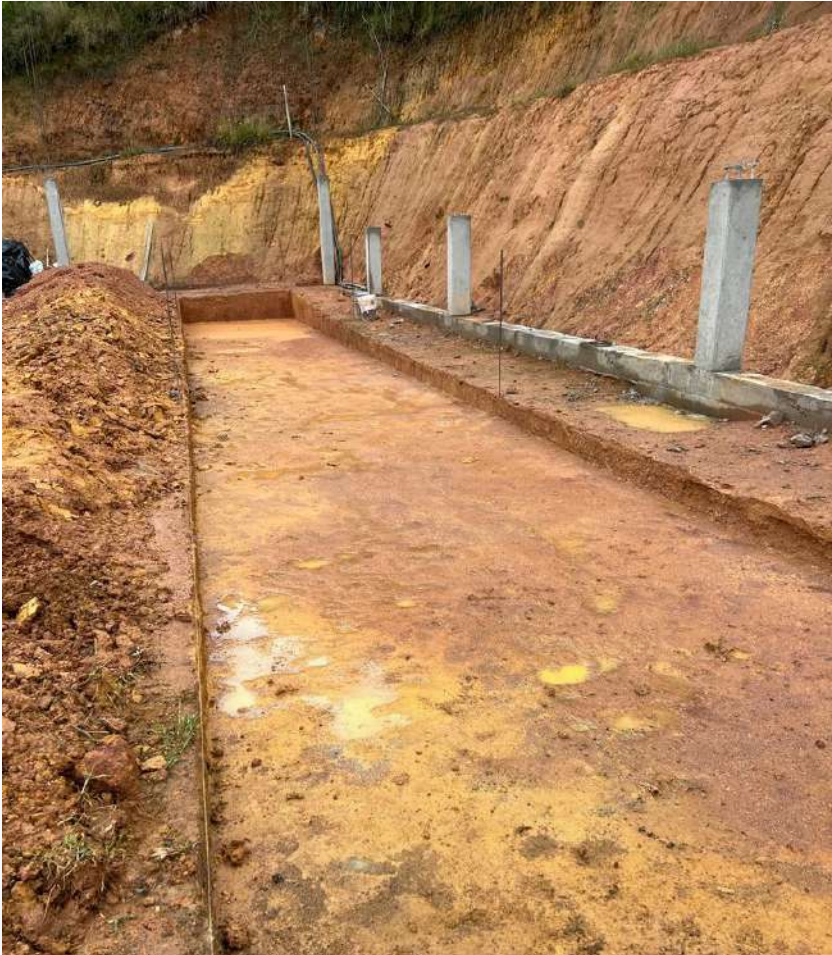
Imagen 55. Excavación y cimentación granja La Virgen.
