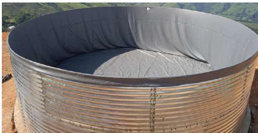
Imagen 38. Tanque australiano en lámina galvanizada.
