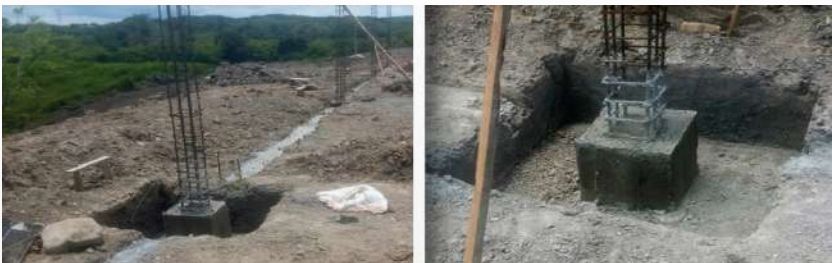
Imagen 57. Cimentación zapata aislada granja Córcega – Risaralda
