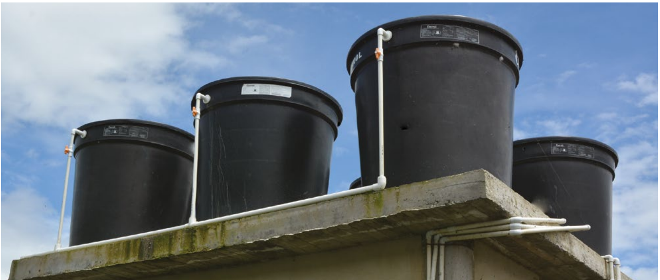
Foto N° 9 Aprovechamiento de agua Lluvia.
