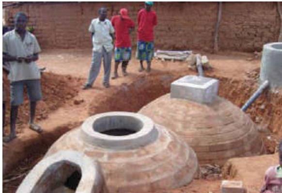
Ilustración 13. Biodigestor tipo chino
