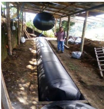
Imagen 7. Biodigestor Convenio 307- 2017 Municipio de Fresno.
