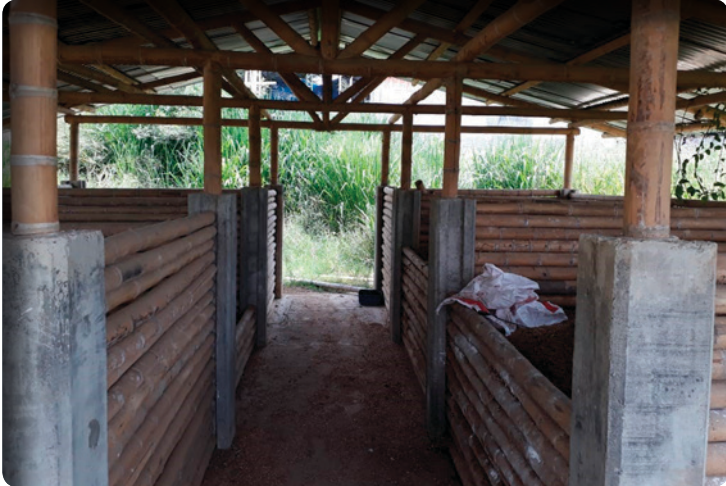
ILUSTRACIÓN 23 ▶ Compost de mortalidad estructura interna Granja Córcega - Risaralda
