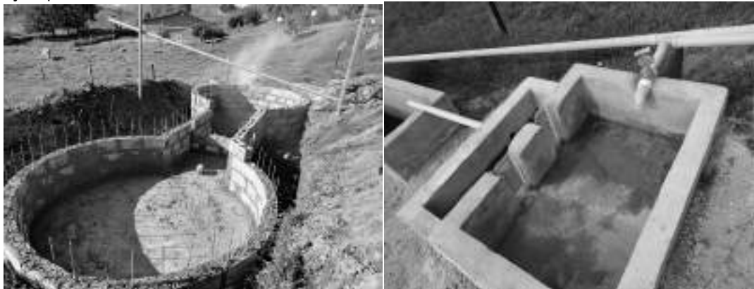
Figura 8: Construcción del equipo de generación con biogás para pequeñas granjas porcícolas.
